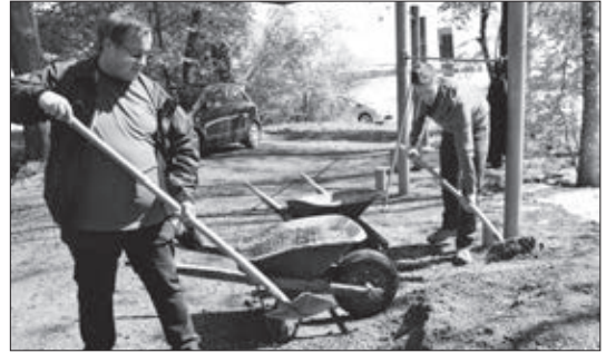
Marcel Stalder und Silvan Buholzer bei schweisstreibender Arbeit.
