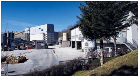
Kieswerk, angrenzend Grundwasserschutzzonen.
