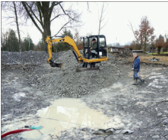
Markus Barmet und Christoph Pürro beim Ausbaggern.
