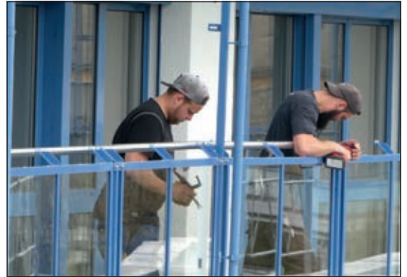
Die Umbauarbeiten im 3. Stock West schreiten voran.
